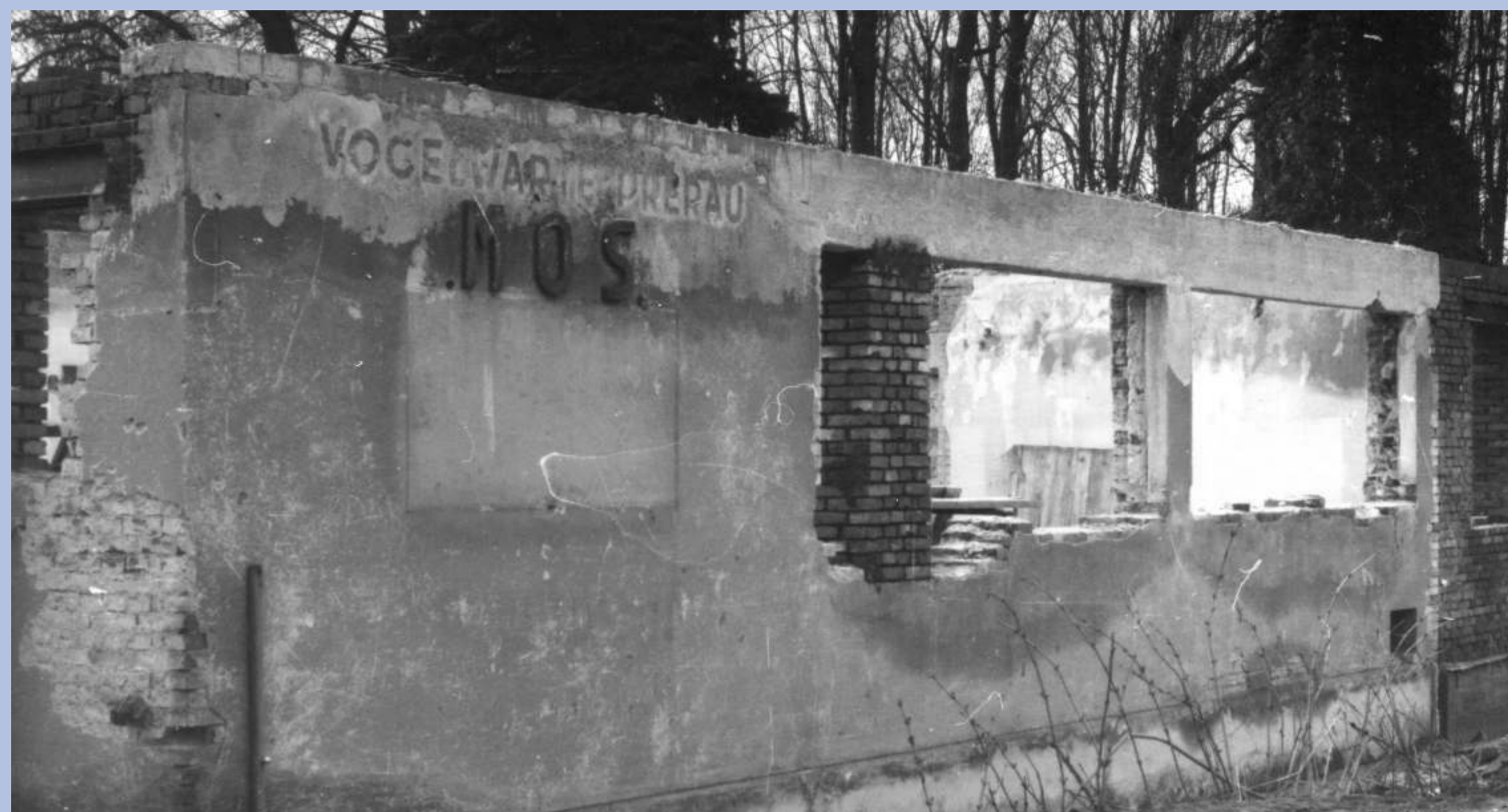
Demolice původní budovy, r. 1979.
