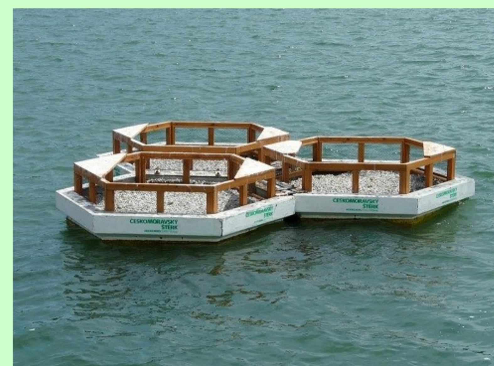
V předjaří roku 2010 byly spuštěny na hladinu Troubeckého jezera další čtyři betonové plovoucí ostrůvky a dalších pět v roce 2011. Jeden betonový ostrůvek váží 3,5 tuny.
